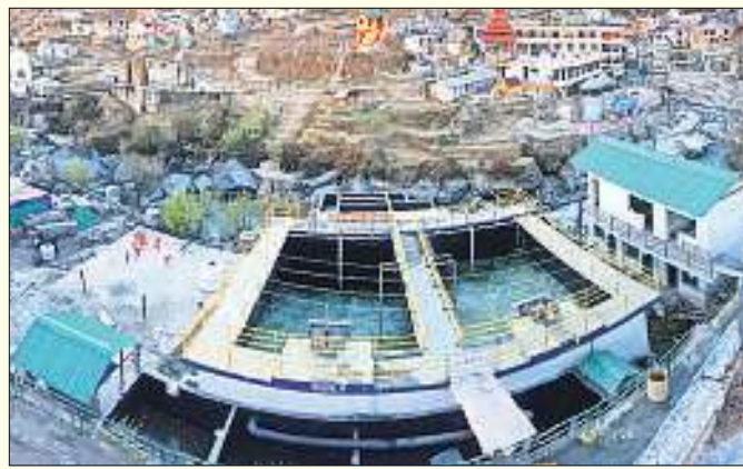
1 MLD STP, Badrinath
